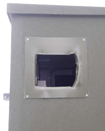
Local Chapelle des Bois 21 jours après mise en service
